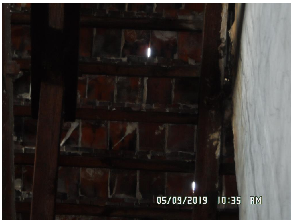
38. Dziury w pokryciu dachowym
