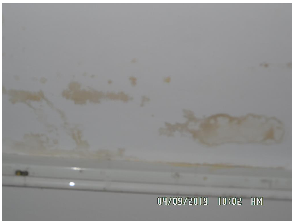
30. Zacieki na suficie w kolejnym pomieszczeniu
