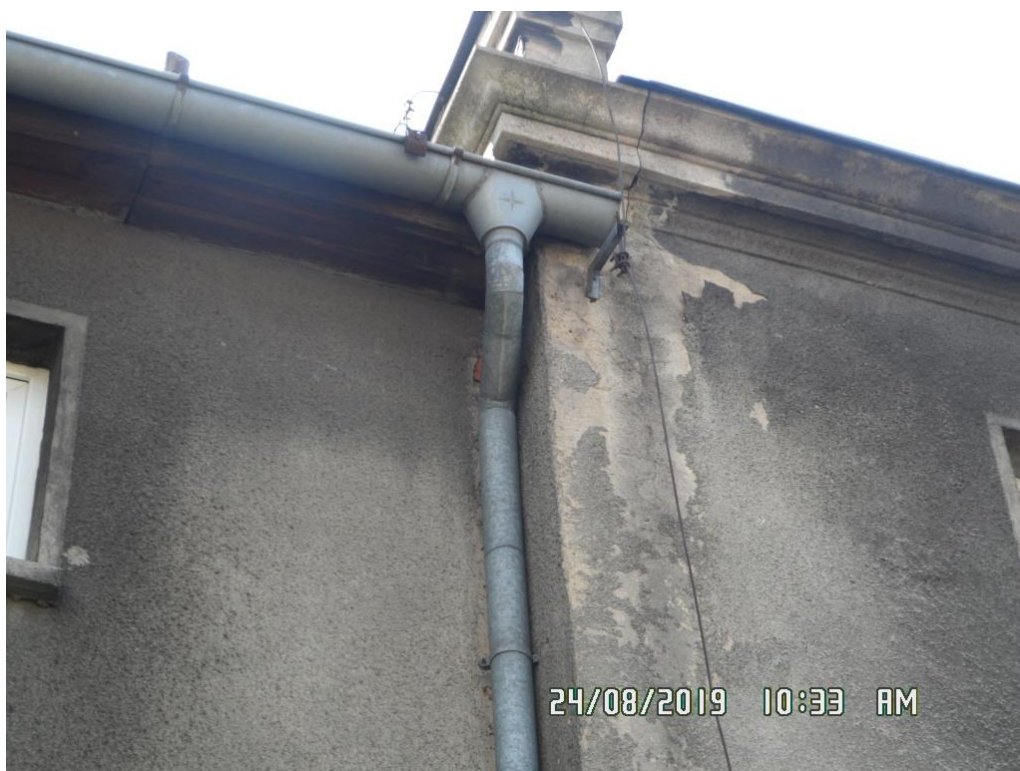
4. Zniszczony tynk i gzyms od strony południowej
