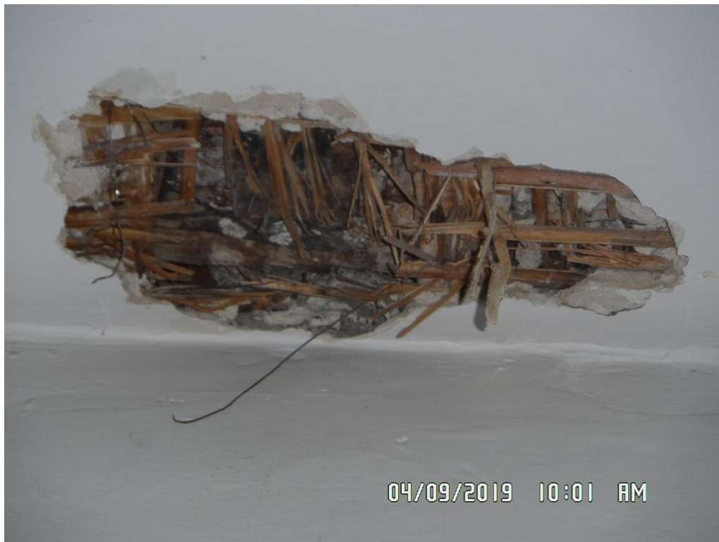
27. Odkrywka stropu nad parterem po stronie północnej
