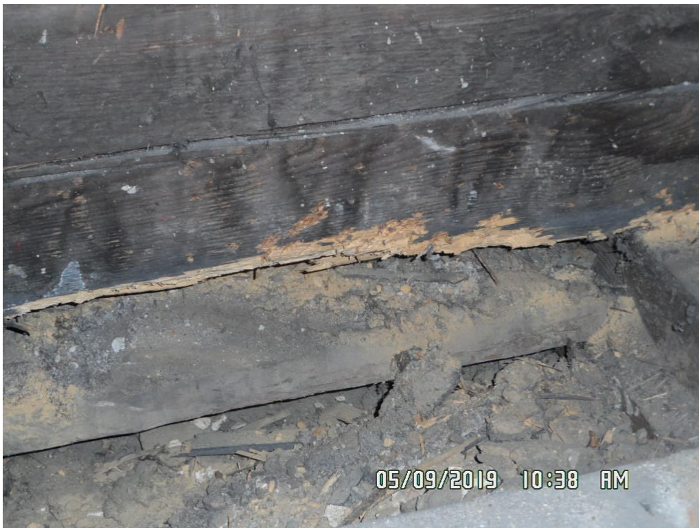
39. Zniszczony – zmurszały podciąg na poddaszu
