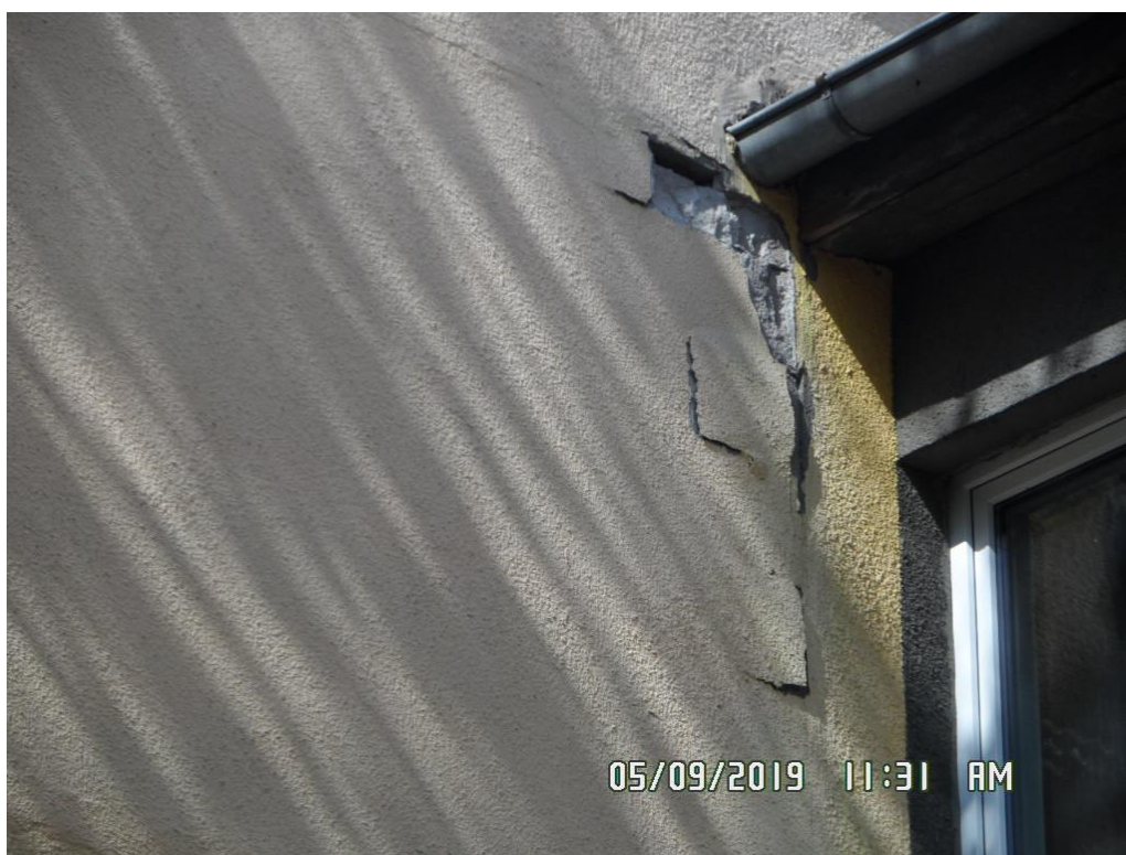
54. Uszkodzony tynk i ściana po stronie południowej
