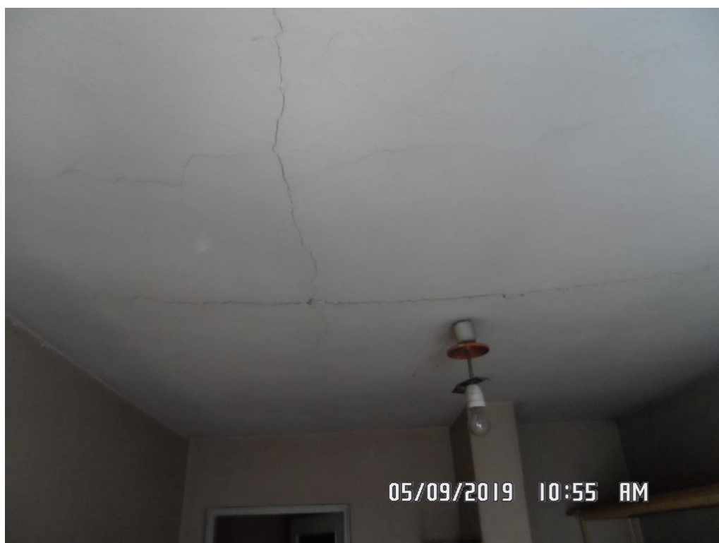
52. Pęknięty sufit powieszany po stronie południowej
