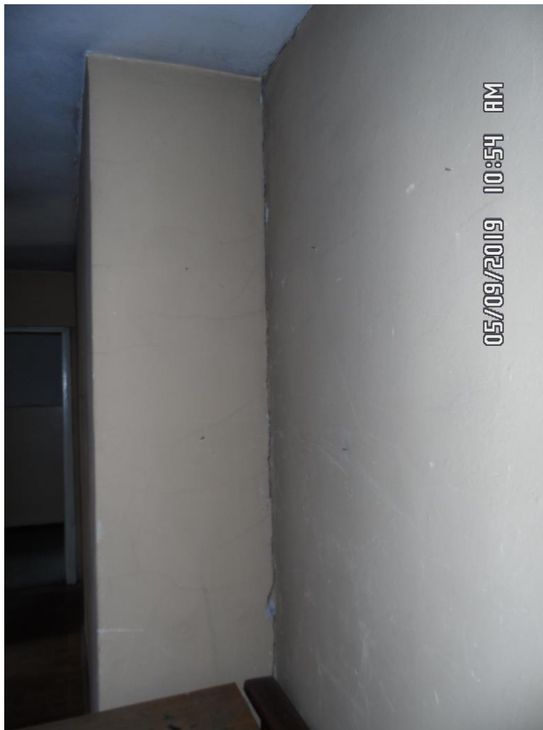
51. Rozwarstwienie ścianek działowych na poddaszu
