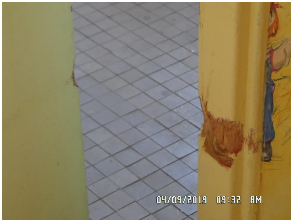
25. Uszkodzona ościeżnica drzwiowa na parterze
