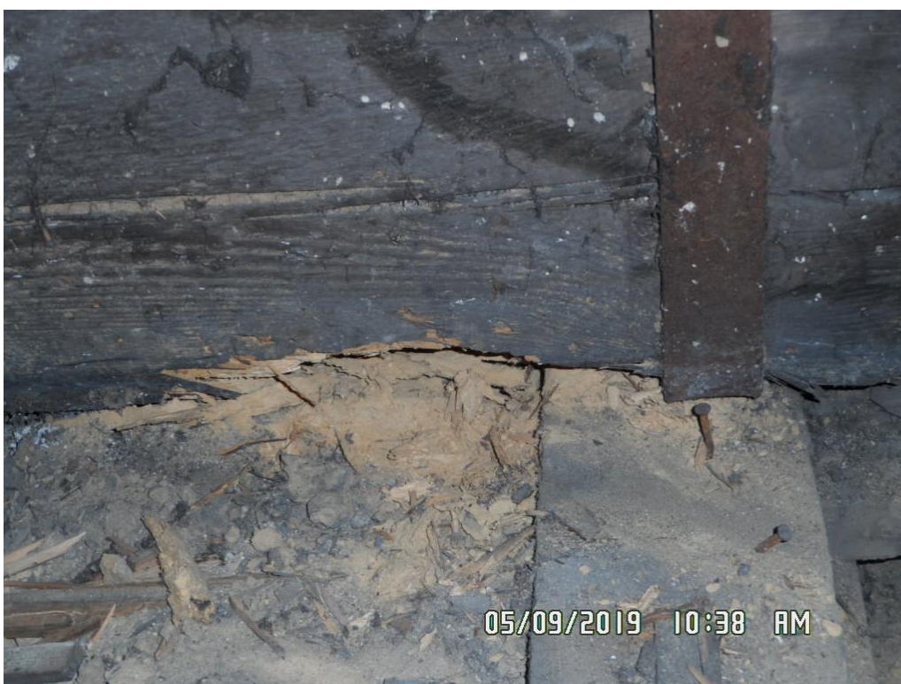
40. Zniszczony – zmurszały podciąg na poddaszu
