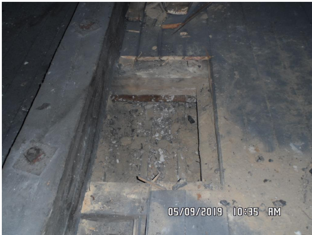
37. Odkrywka stropu nad piętrem
