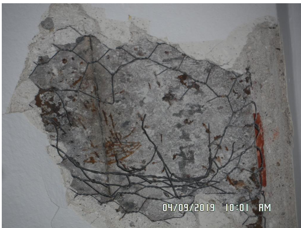
28. Odkrywka podciągu stalowego po stronie południowej
