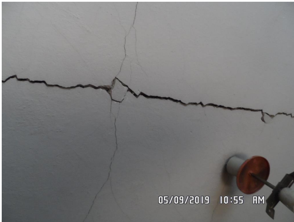
53. Pęknięty sufit powieszany po stronie południowej
