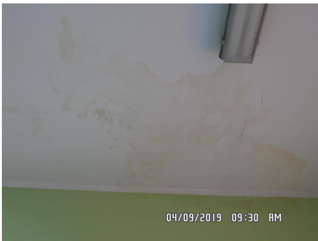
24. Zacieki na suficie na parterze
