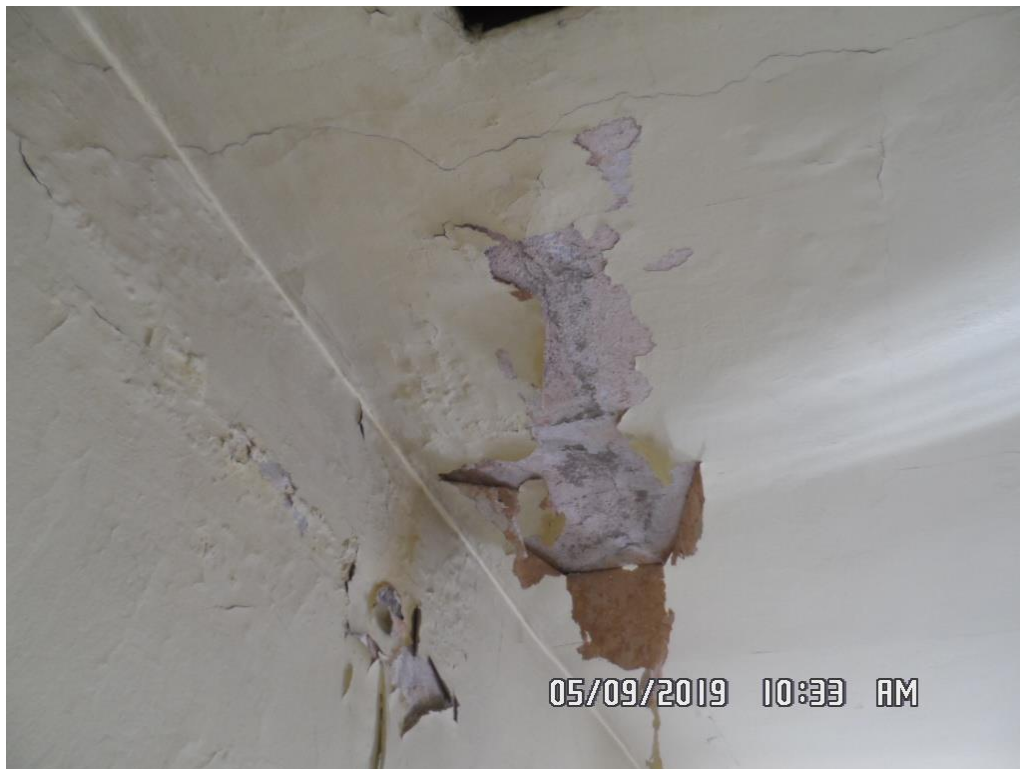
33. Odpadający tynk na suficie w piwnicy
