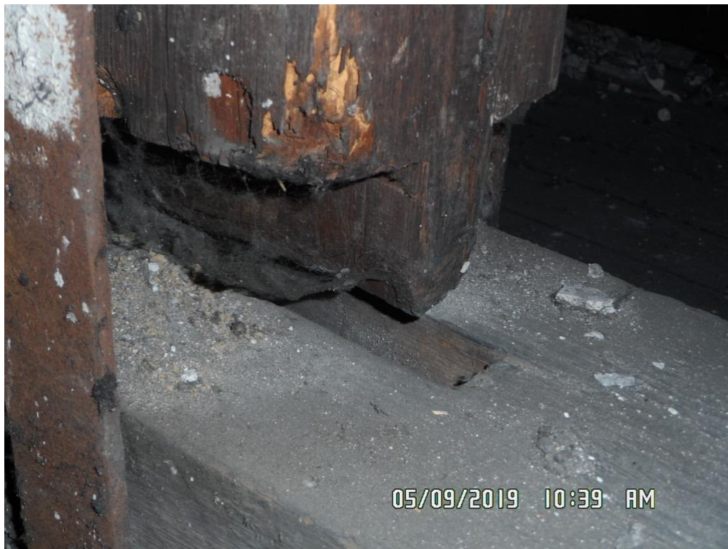
41. Wysunięty czop słupa z gniazda podciągu
