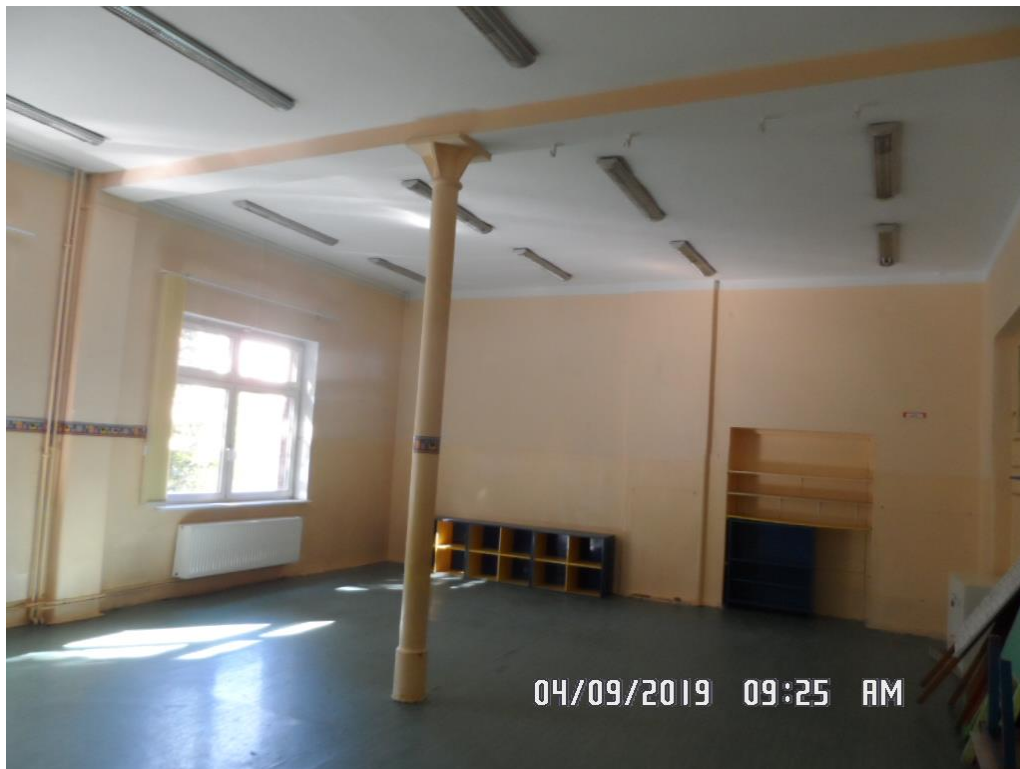
21. Słup stalowy i podciąg po stronie południowej (na parterze)
