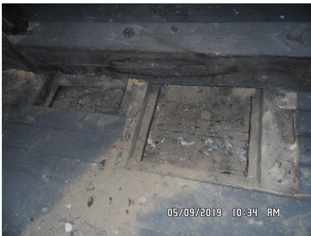
36. Odkrywka stropu nad piętrem
