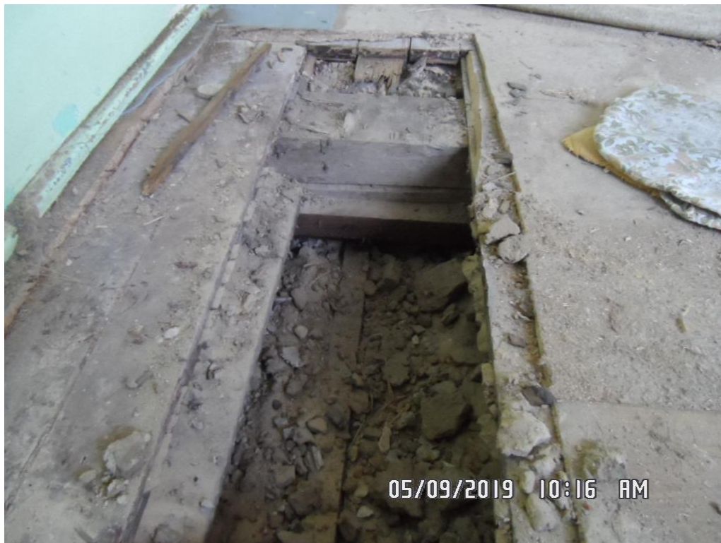
31. Odkrywka stropu drewnianego nad parterem
